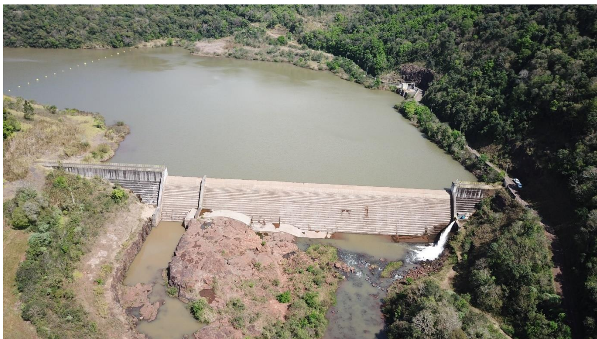
Figura 11 – Vista Geral da Barragem
