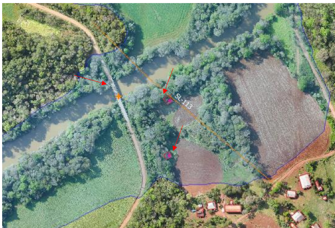
Figura 27 – Localização ponte 1 e propriedades - SL-113
