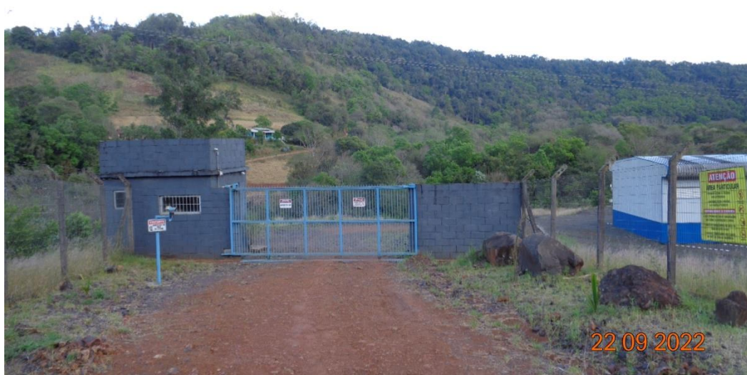
Figura 20 – Muro, cercas e portão de acesso a Casa de Força
