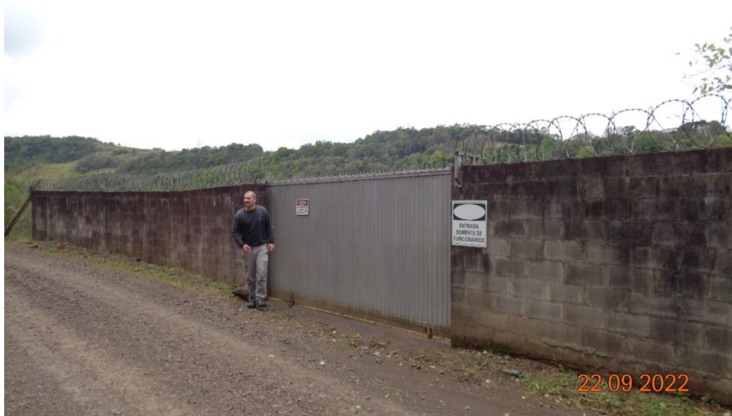
Figura 24 –Muro e portão de acesso a Barragem
