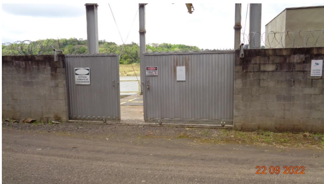
Figura 23 –Muro e portão de acesso a tomada d'água
