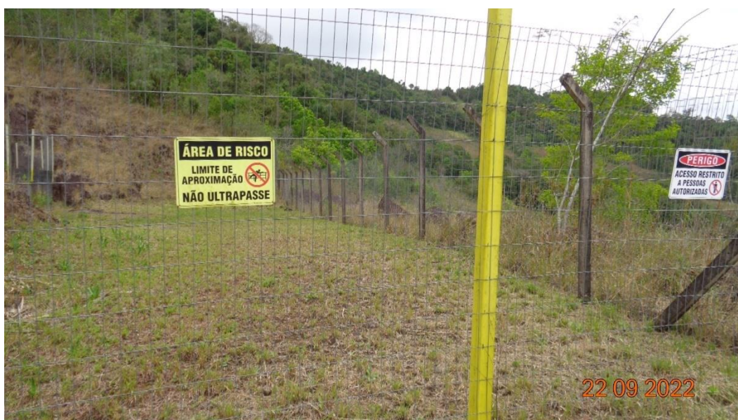
Figura 22 – Portão e cercas da Chaminé de Equilíbrio
