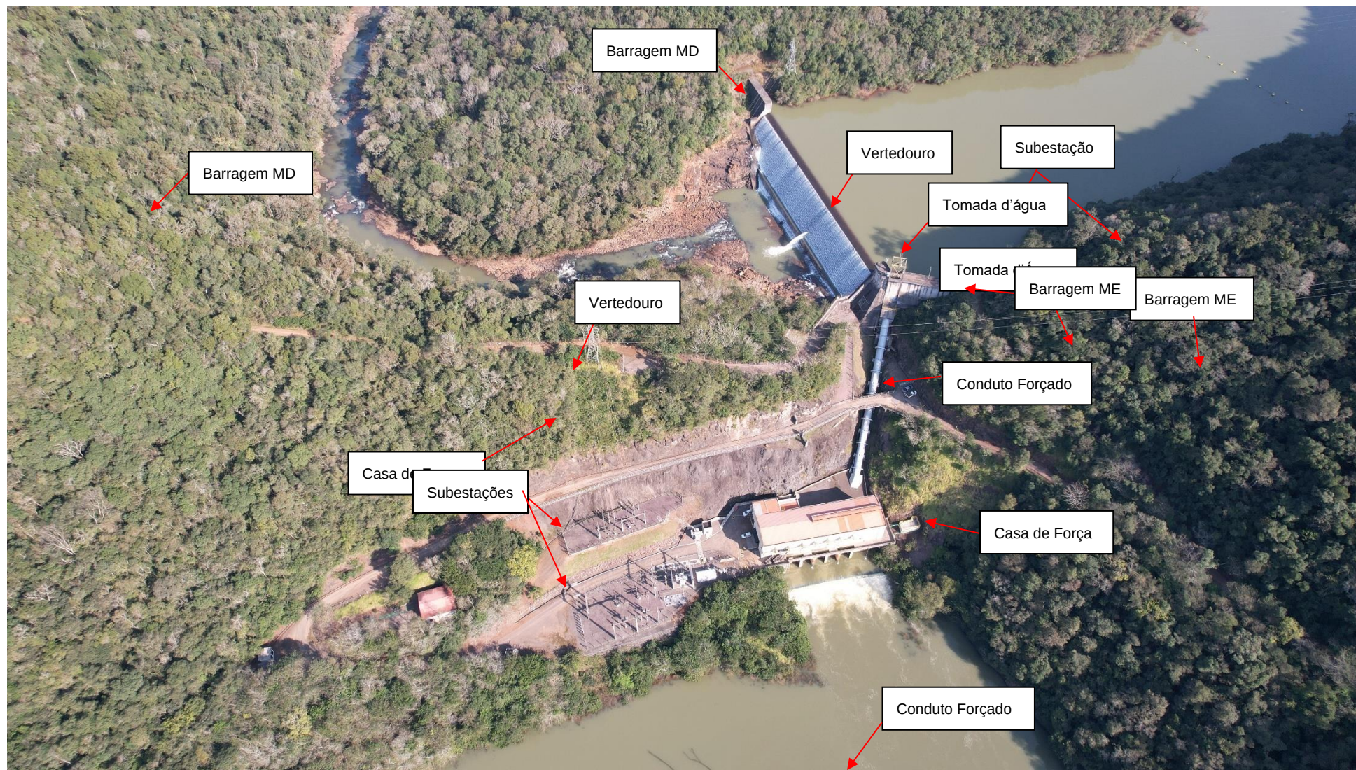
Figura 1 – Estruturas da PCH São Bernardo
