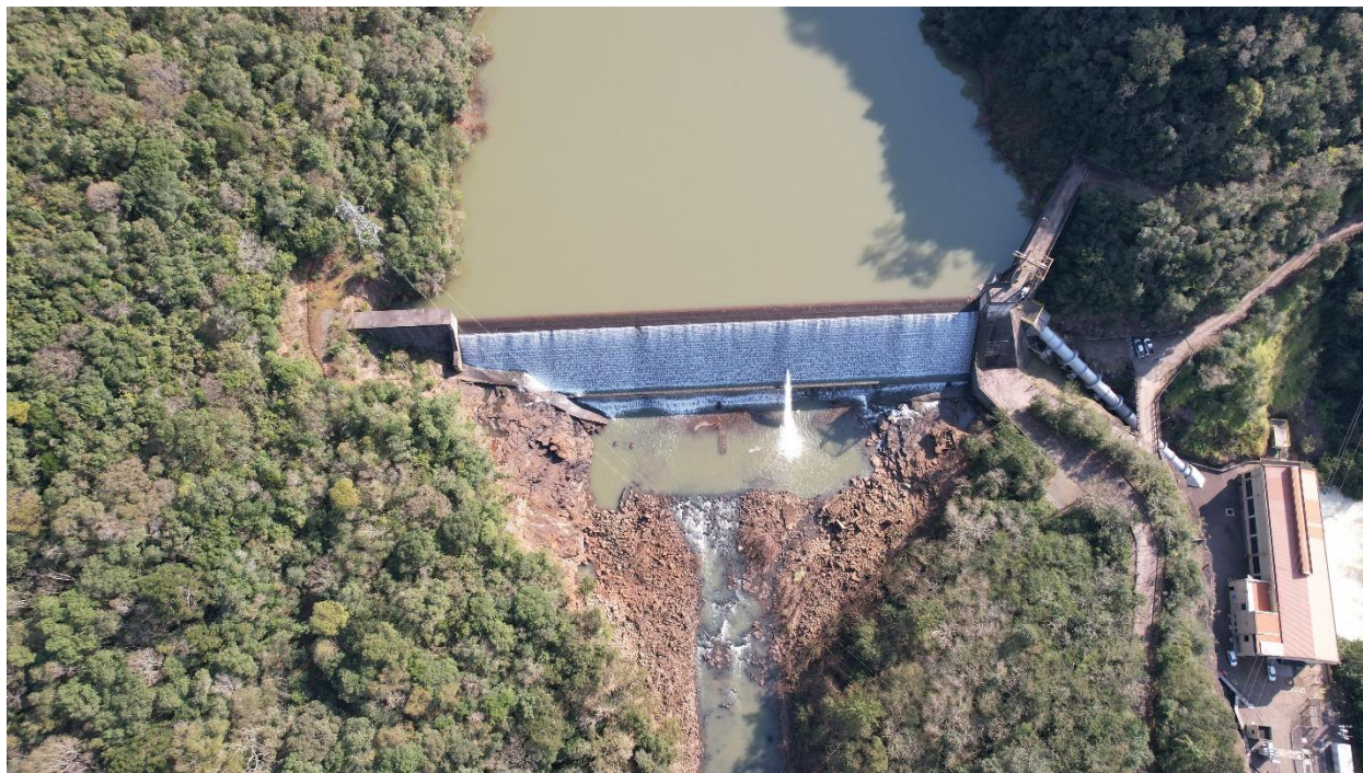
Figura 17 – Superfície do Vertedouro de soleira livre
